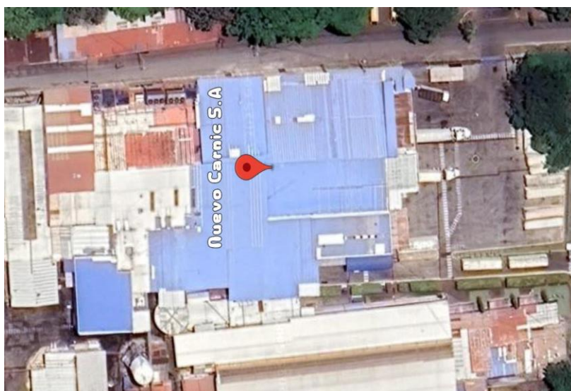
Figura 11. Vista aérea y georreferencia del Matadero Nuevo Carnic S.A.
