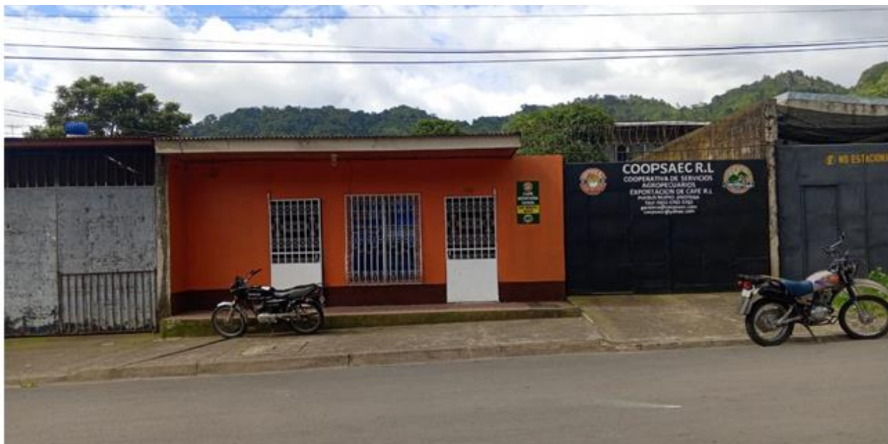
Anexo 8. Fotos: Fachada de las oficinas centrales de COOPSAEC R.L en la ciudad de Jinotega.
