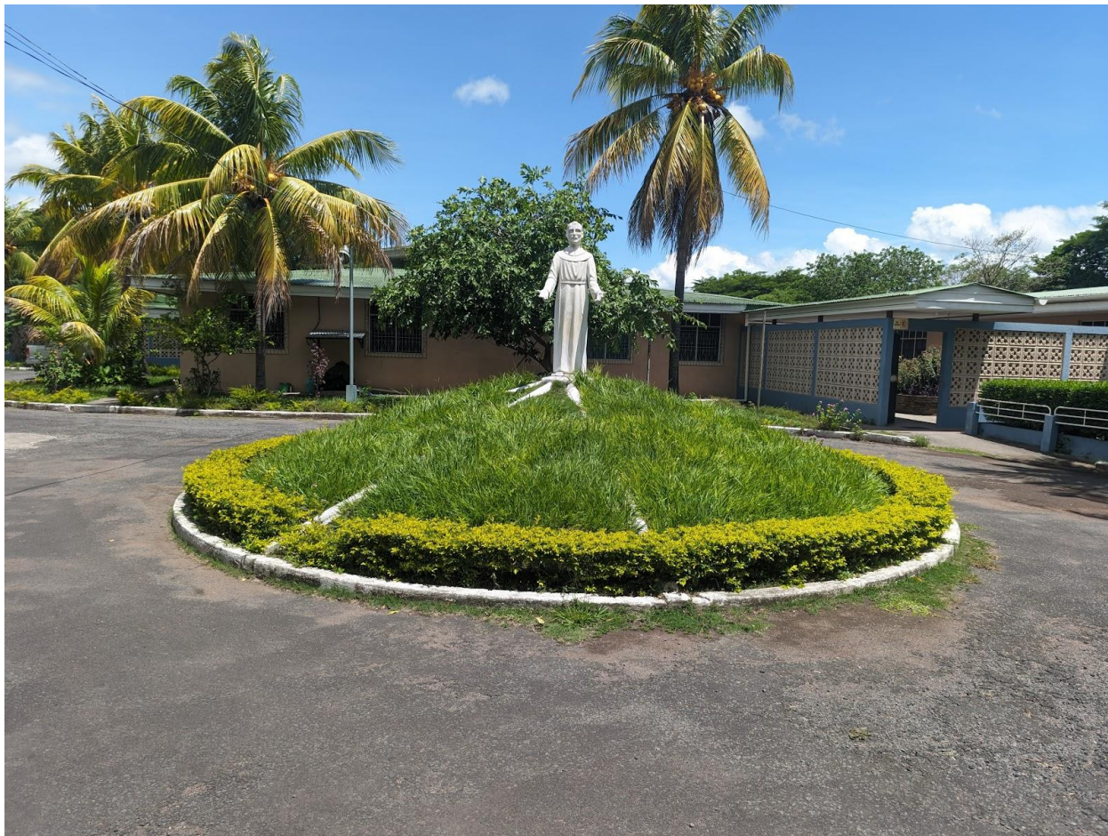
Fotografía 1. Instalaciones Del Hogar De Ancianos San Francisco De Asís, Municipio De Sebaco, Matagalpa.
